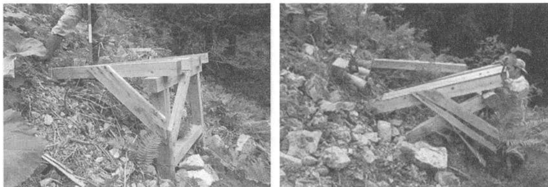
図-3. スノーレーキの雪圧害 写真左は壊れなかったが、右は筋交いが外れて倒壊した。
