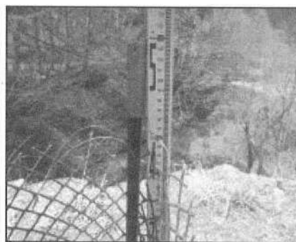
写真-2. 破損状況(資材B)
